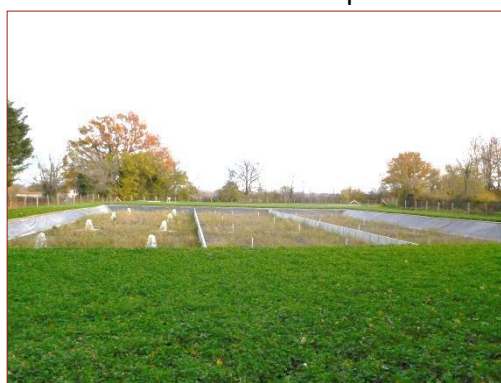
1 er bassin planté de roseaux
