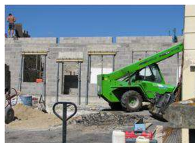
Construction de la nouvelle cantine avec étêtement du toit et rehausse des murs
