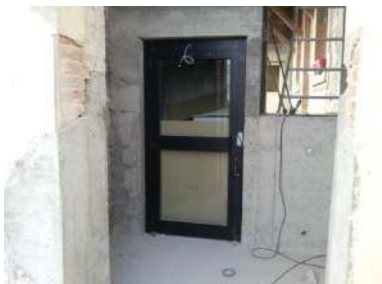
Construction de l'ascenseur desservant l'école et la mairie
