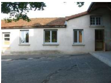
Bâtiment qui abritera la nouvelle cantine
