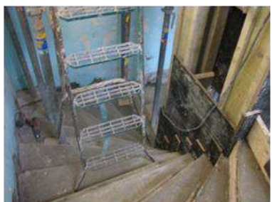
Construction d'un escalier béton pour accès au 1 er étage
