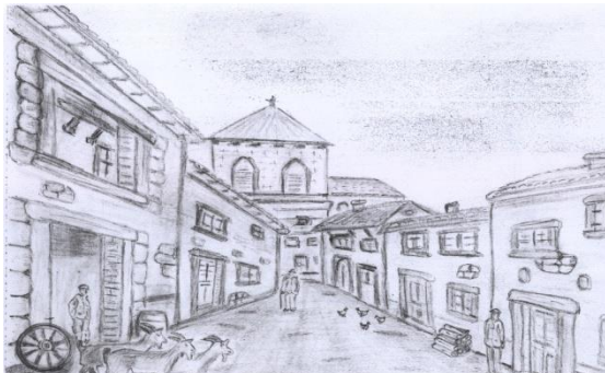
à gauche Maisons non reconstruites de l'îlot triangulaire
